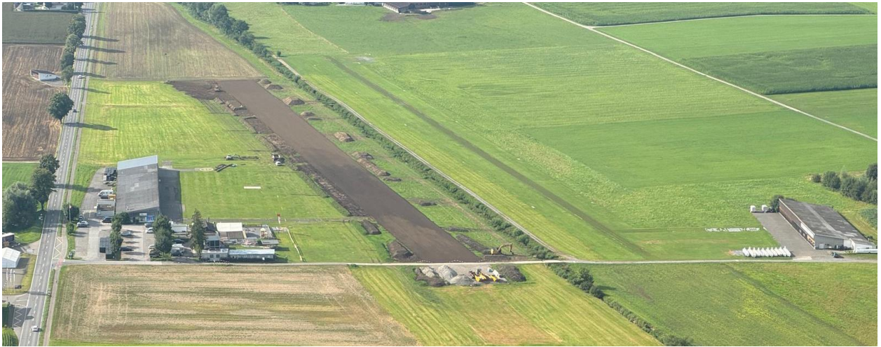
30. Juli 2024: Die Kofferung ist mit einer Humusschicht überdeckt und angesät
