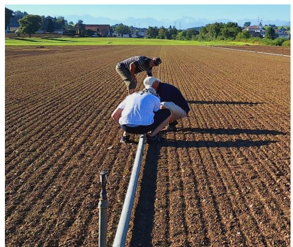
10. August 2024 Die Bewässerungsleitung wird verlegt
